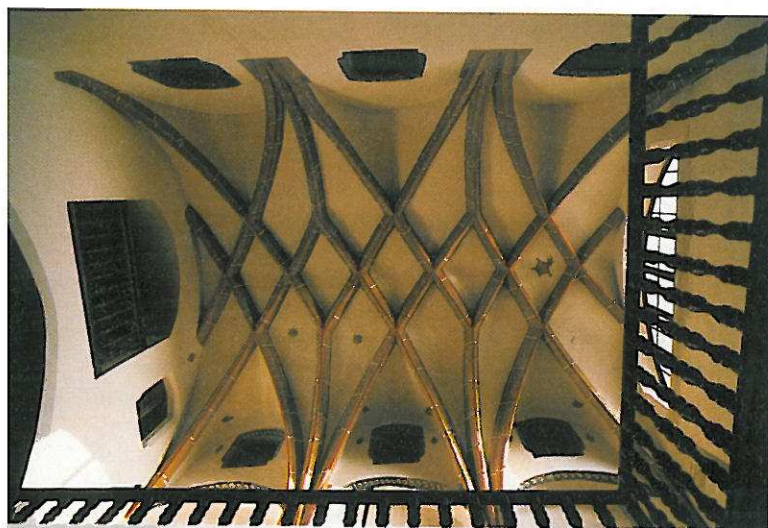
Kleinod der Renaissance: Netzrippen- gewölbe einer Zentralhalle am Untermarkt
